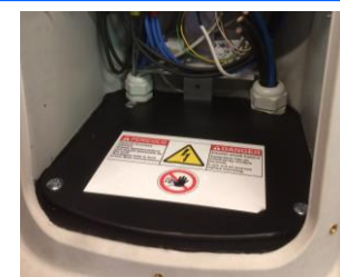
setto divisorio in PE a tenuta per la separazione delle componenti idrauliche da quelle elettriche.
